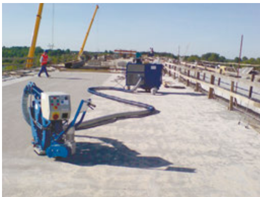
Рис.6 Дробеструйная очистка поверхности металла
