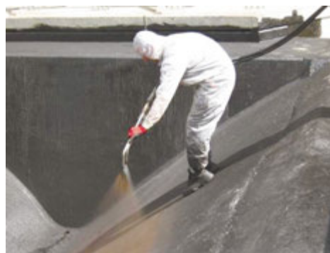
Рис.5 Струйно-абразивная обработка поверхности ортотропной плиты: а) пескоструйный аппарат б) процесс очистки металла
