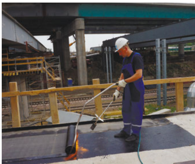
Рис.12 Наплавление гидроизоляционного материала
